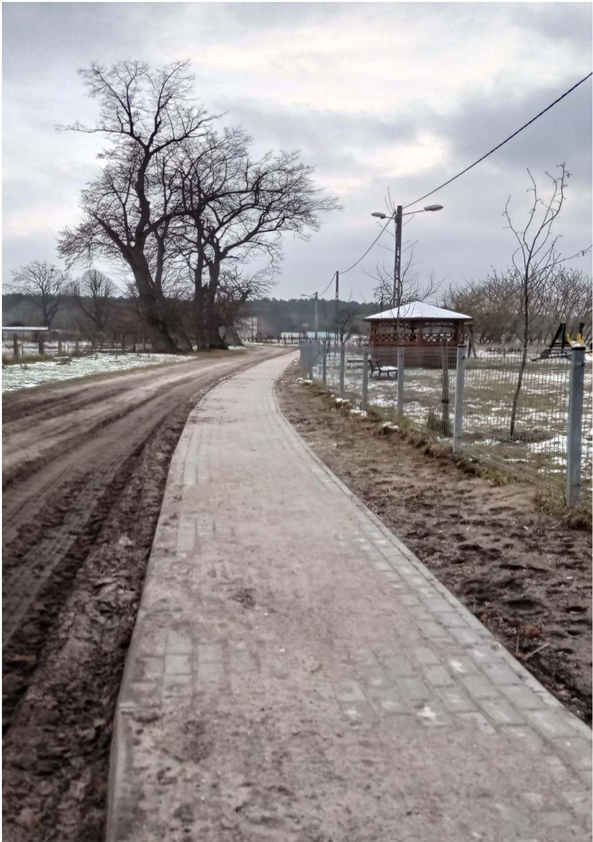
Fot. Budowa chodnika w m. Piasek
