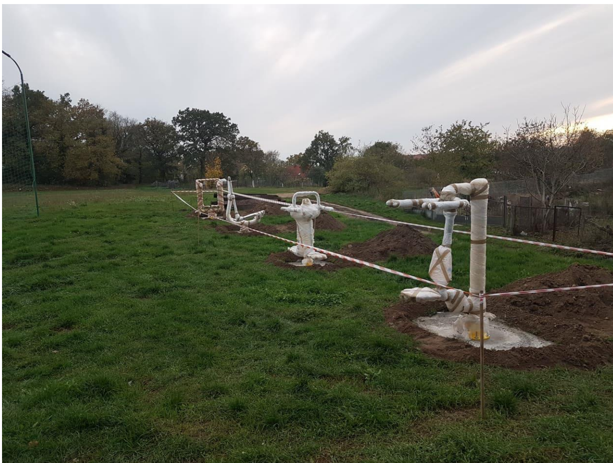
Fot.: Montaż siłowni zewnętrznej w Radostowie w ramach Grantów Sopleckich.
